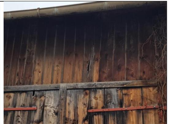
Abb. 3 Spalten in der Fassade Fl.St. 857/1
