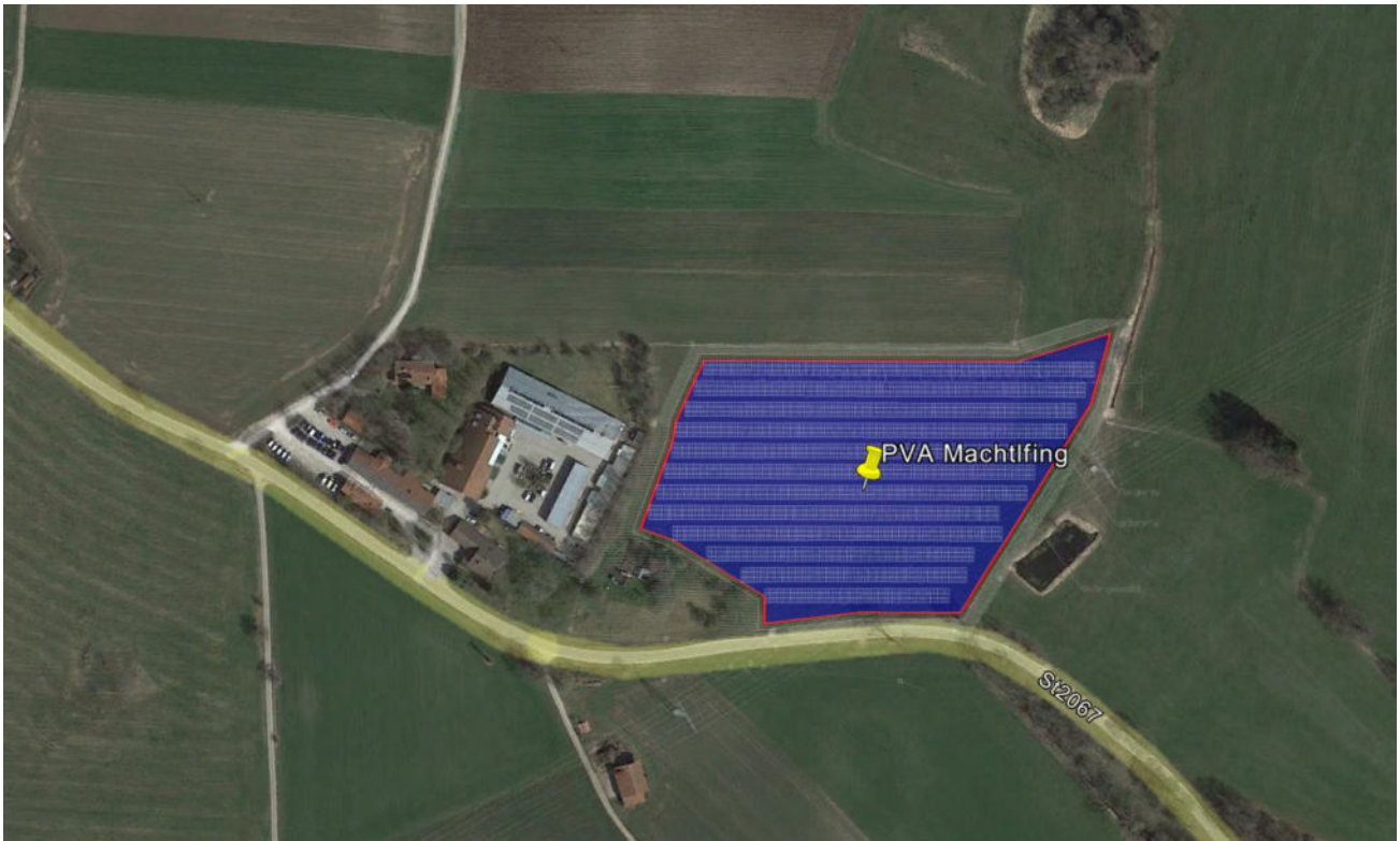
Bild 2.1.2: Übersicht über die PV-Anlage und Umgebung (Google Earth/SolPEG)
